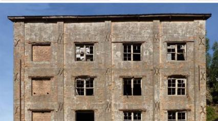
Los tirantes con anclajes metálicos distribuidos en toda la fachada del molino, consolidan la estructura interna de madera y su perímetro de albañilería.
