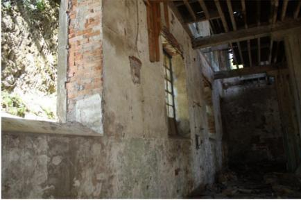
Muro perimetral de albañilería de 85cm de espesor. Funciona como envoltorio de toda la maquinaria interna.
