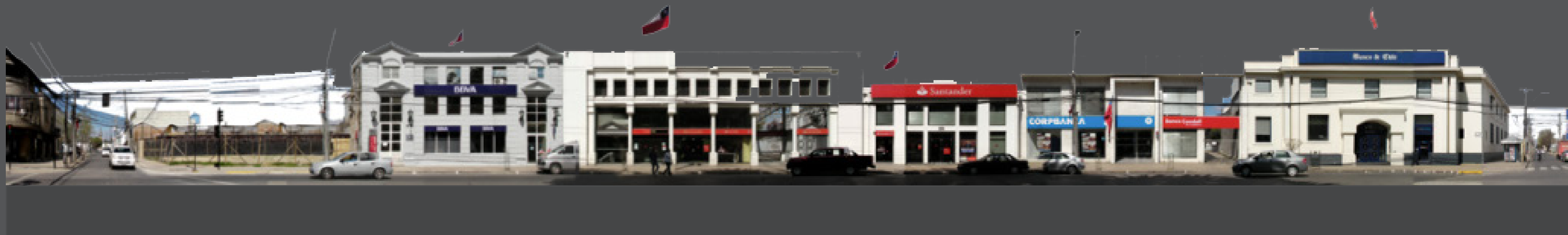
Figura 10: Fachada Sur Fuente: Fotografías elaboradas por la arquitecta Karla Macías
