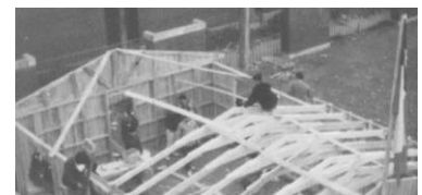
Ilustración 48 Construcción gimnasio Doñihue
