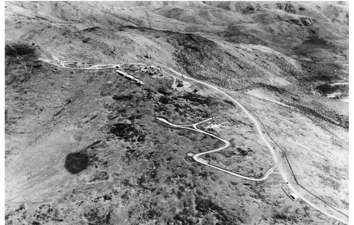
Fig 32. Inicios de obra de la ciudadela en el cerro La Silla. extraído de ESO.org
