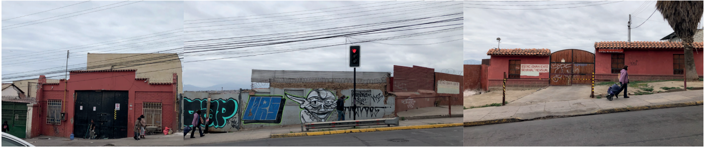
Fachada Sur calle Cantournet Imagen 19. Fuente: Elaboración propia.
