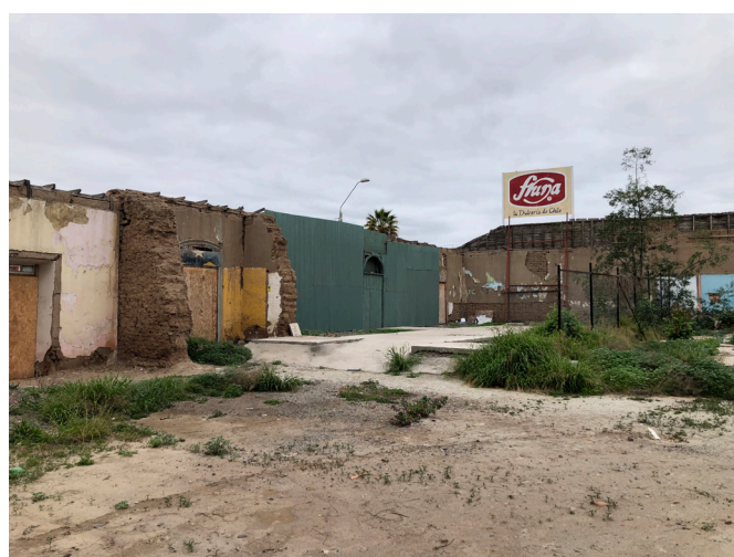
Interior del predio Imagen 30. Fuente: Elaboración propia.
