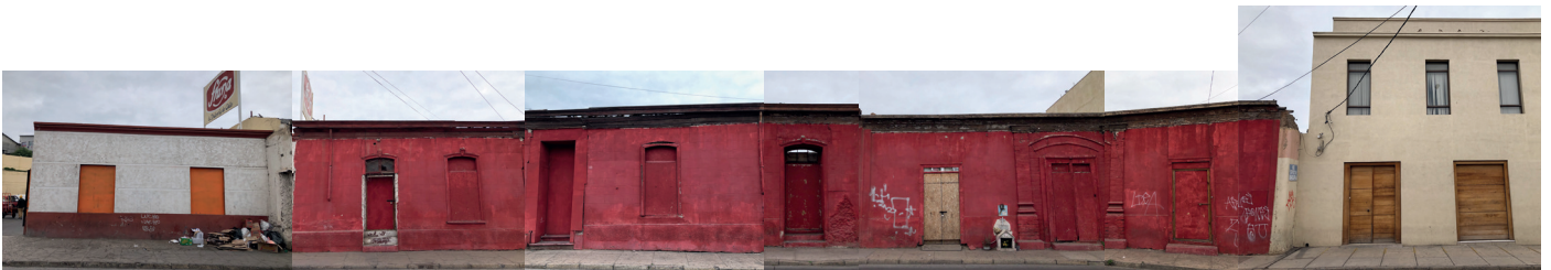
Fachada Norte calle Vicente Zorrilla Imagen 20. Fuente: Elaboración propia.
