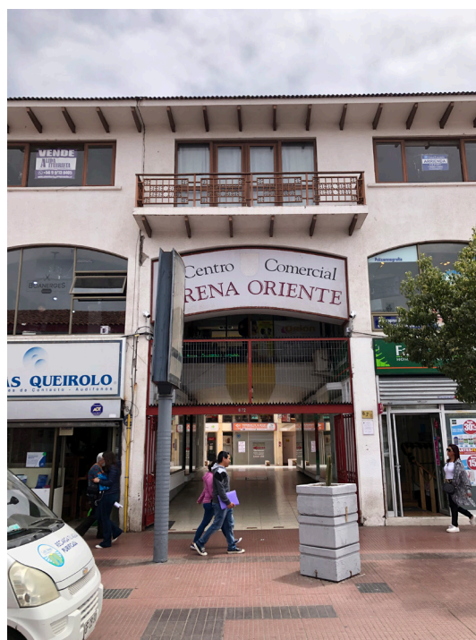
Fachada Centro comercial Serena Oriente Imagen 4. Fuente: Elaboración propia.
