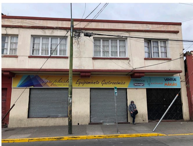
Edificios de comercio calle Vicente Zorrilla Imagen 23. Fuente: Elaboración propia.
