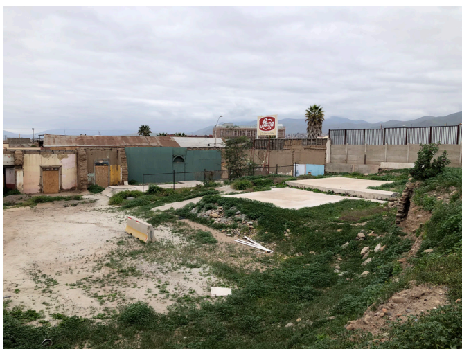
Interior del predio Imagen 29. Fuente: Elaboración propia.
