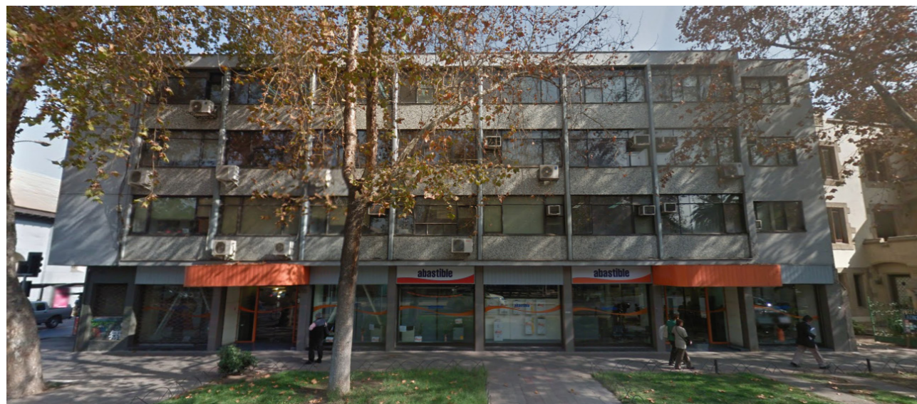
Fig. 13 Avenida Vicuña Mackenna #61 Oficinas Abastible S.A. 2014 Fuente: Google Earth (2022)
