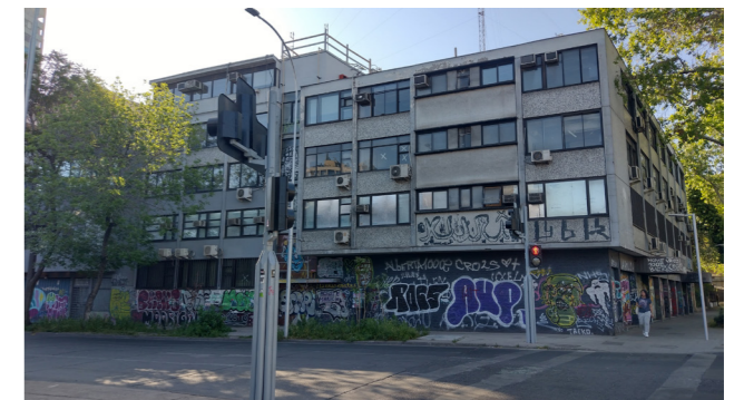
Esquina VM61, acceso principal a oficinas
