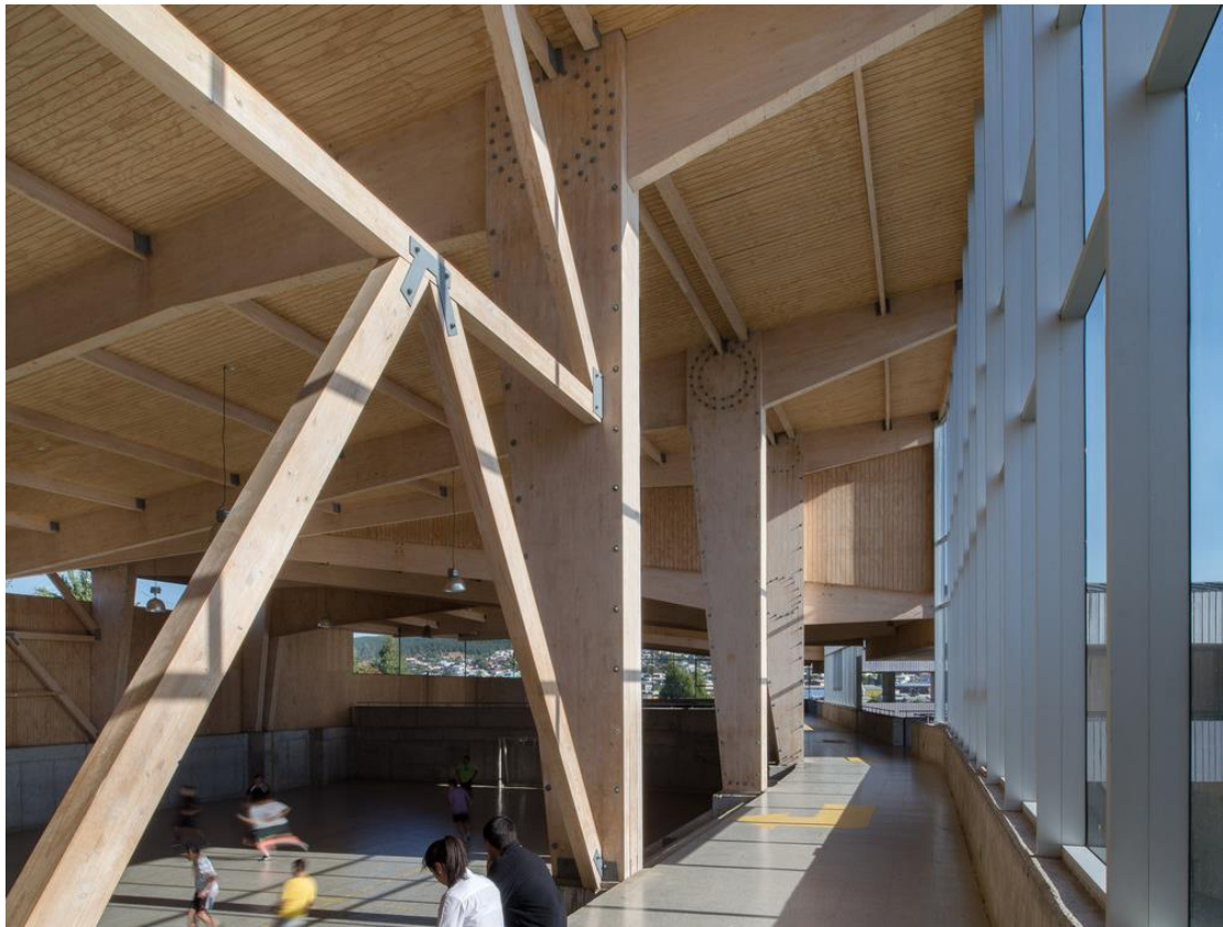
Figura 57: Referente: Escuela Curanilahue, Chile. Arquitectos: Macchi - Jeame - Danus & Boza - Boza - Labbé - Ruiz Risueño. Obtenido de: www.archdaily.cl
