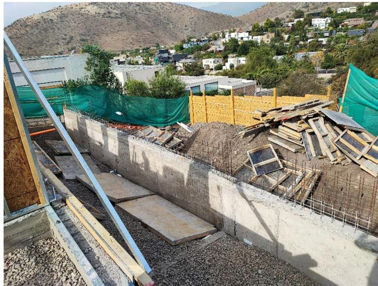
Figura 3.2.6: *Ejecución de muro de contención en terreno para deck de terraza.*
