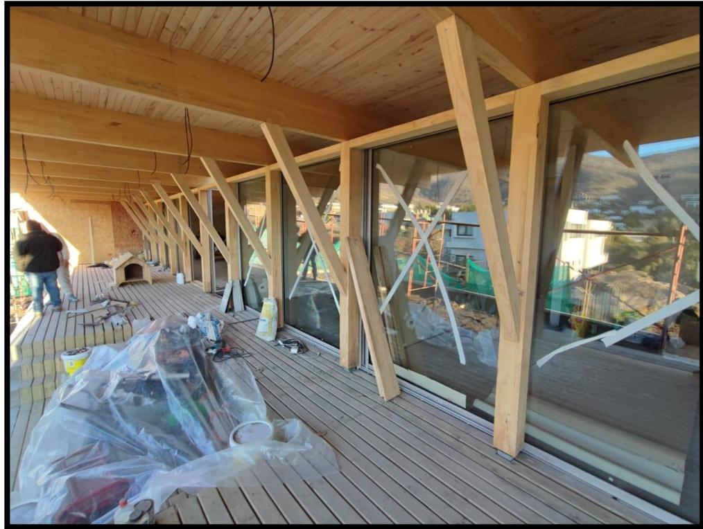
Figura 5.2.8: *Estructura de madera para cielo.*
