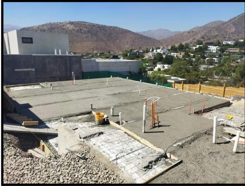
Figura 5.2.4: *construcción de radier hidrófugo.*
