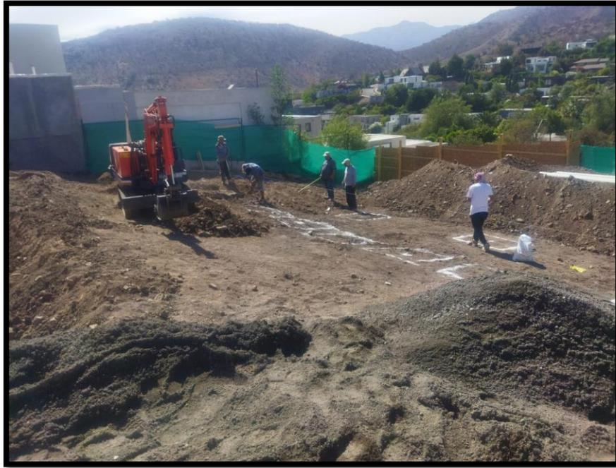
Figura 5.2.2: *Remoción de arcilla expansiva y posterior trazado de fundaciones*
