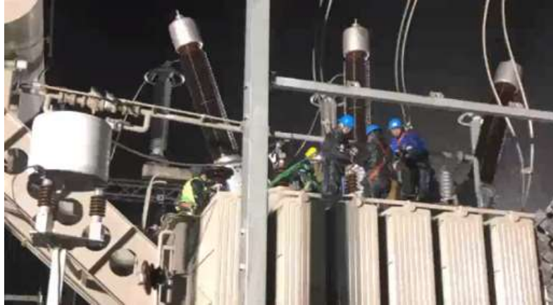
Figura 27: Cambio de transformador en falla en S/E Melipulli de la empresa STS
