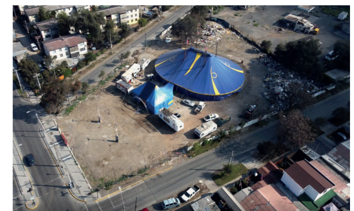
Figura 22: Fotos aéreas emplazamiento Fuente: Elaboración propia
