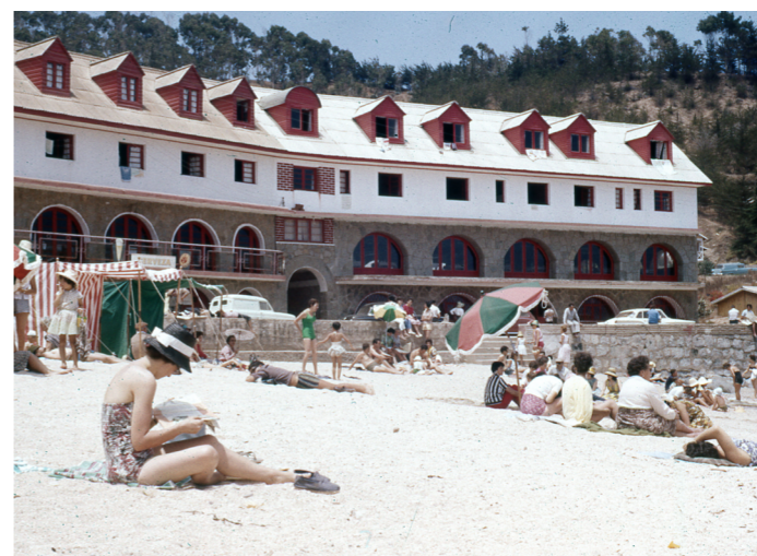
◀ Fotografía: Hotel Maitencillo, 1977. Fuente: Nicolás Labadia, Enterreno Chile.
