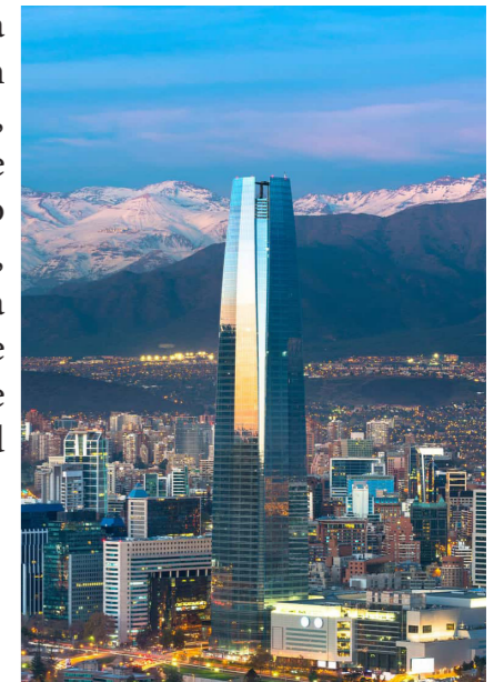
Costanera Center Fuente: https://www.chile.travel/donde-ir/destino/santiago-capital/
