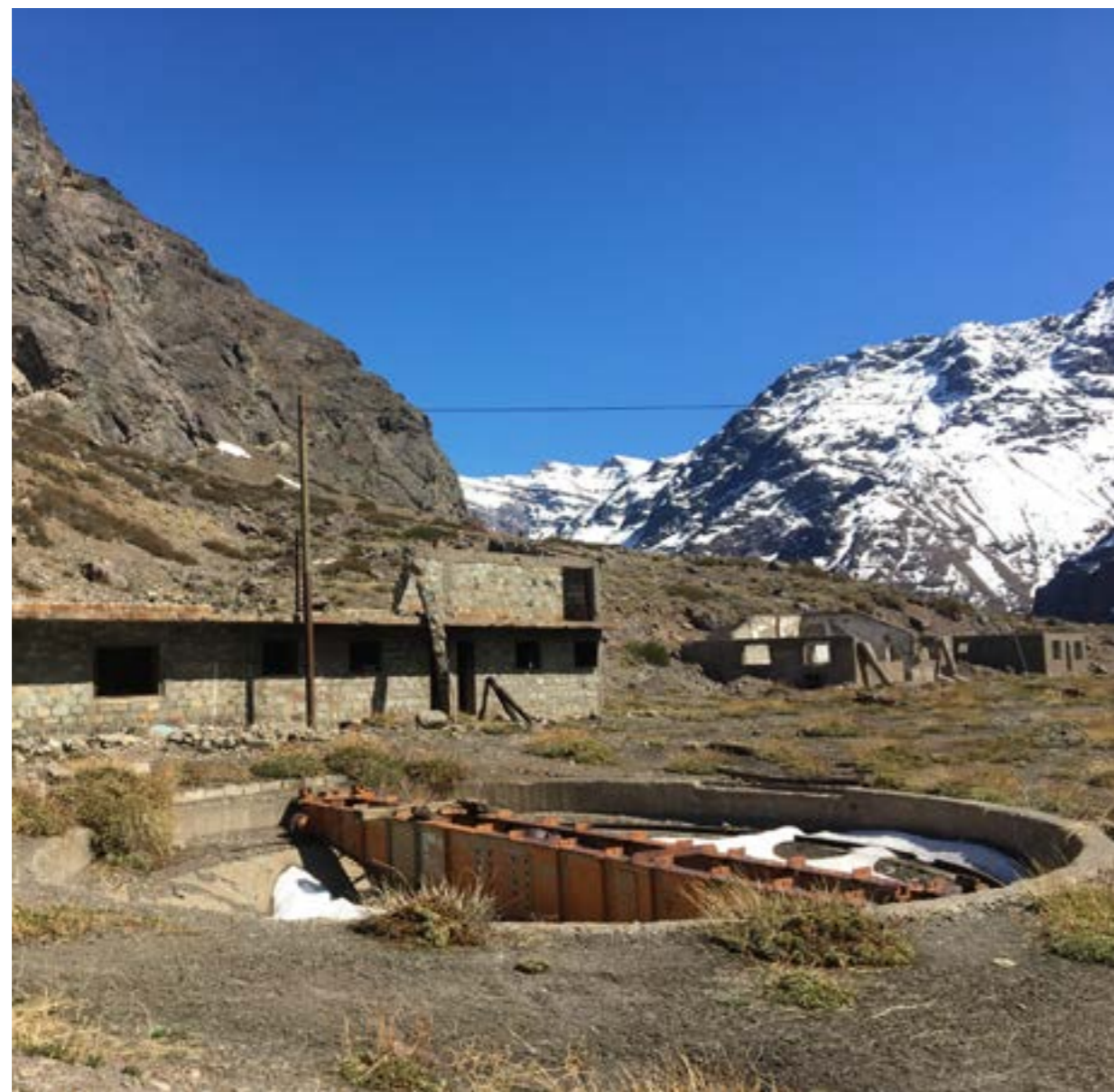
Fig. 11. Restos de infraestructura ferroviaria de la ex- estación Juncal. Elaboración propia.
