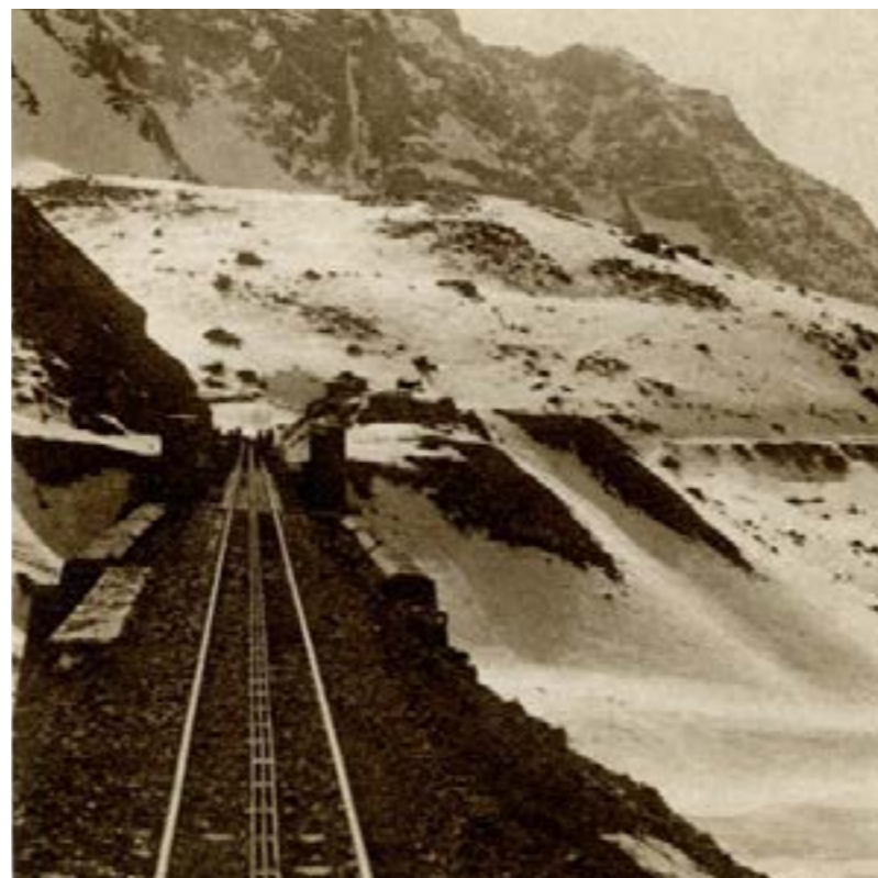
Fig. 8. Infraestructura ferroviaria en la Cordillera de Los Andes - Chile. Puente Portillo. [Fotografía] / Hume y Walker. Chile. [Entre 1910 y 1920].
