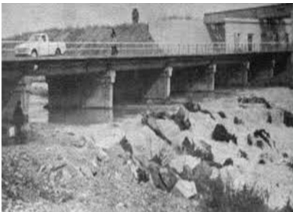
Figura N° 23: Antiguo Puente Bulnes. Fuente: Fotografía. Bajada de link https://huellas.cl/puente-bulnes-y-muro-de-la-memoria/
