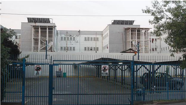
Figura 6. Vista Exterior, Cárcel de Mujeres de San Miguel. Obtenido de: http://www.nuevopoder.cl/fisco-pagara-1-000-millones-a-familiares-de-victimas-de-incendio-en-carcel-de-san-miguel/
