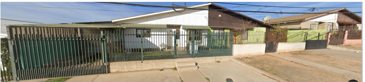
Imagen 34 Viviendas al Este del Predio
