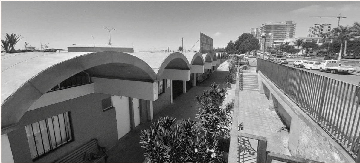
Fotografía 4: Vista hacia la cubierta de la Estación Terminal Arica - Tacna Fuente: Elaboración propia
