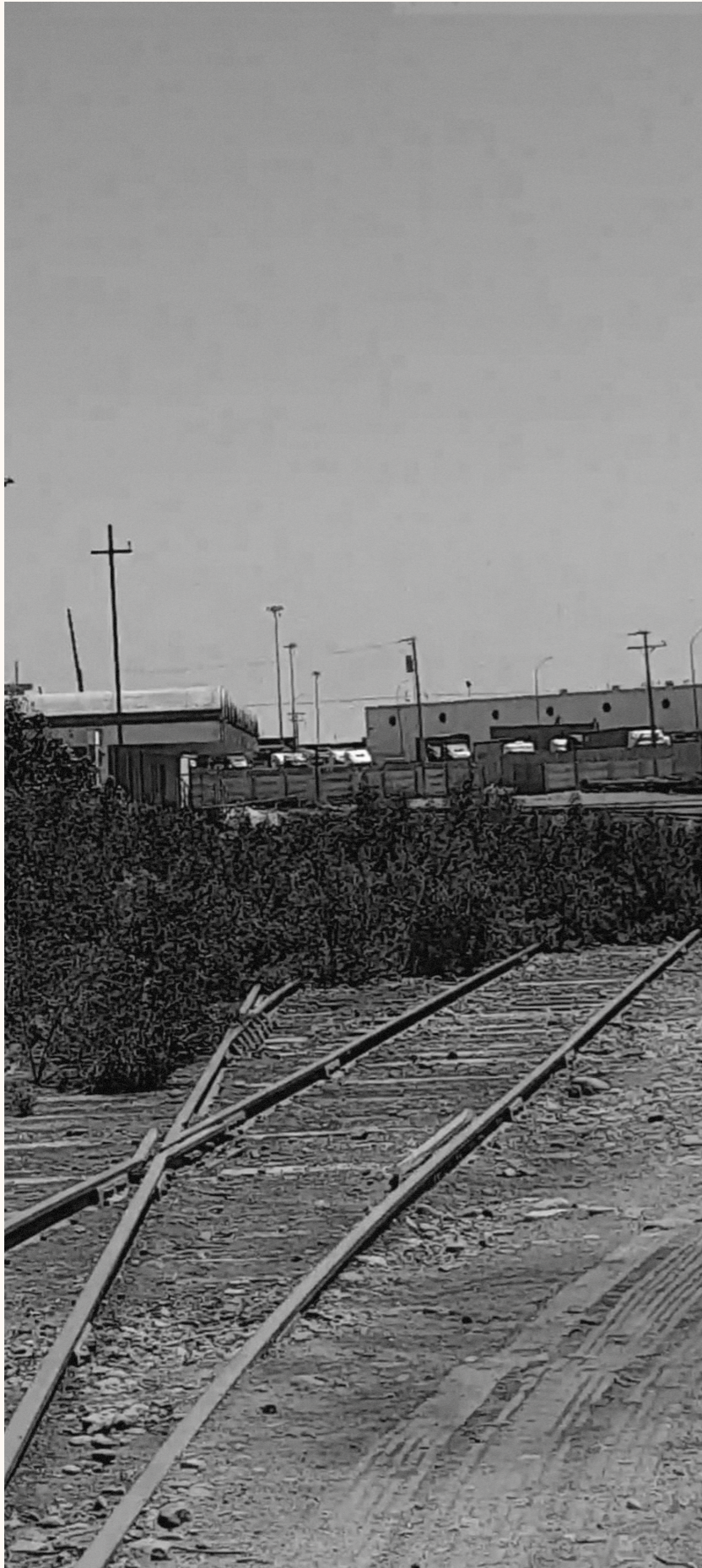
Fotografía 3: Deterioro de las instalaciones de la Estación Terminal Arica -Tacna Fuente: Elaboración propia
