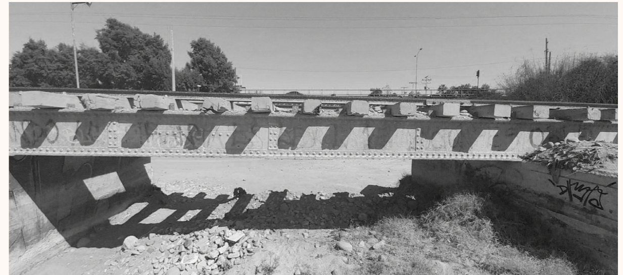
Fotografía 2: Puente ferroviario del Río San José Fuente: Elaboración propia
