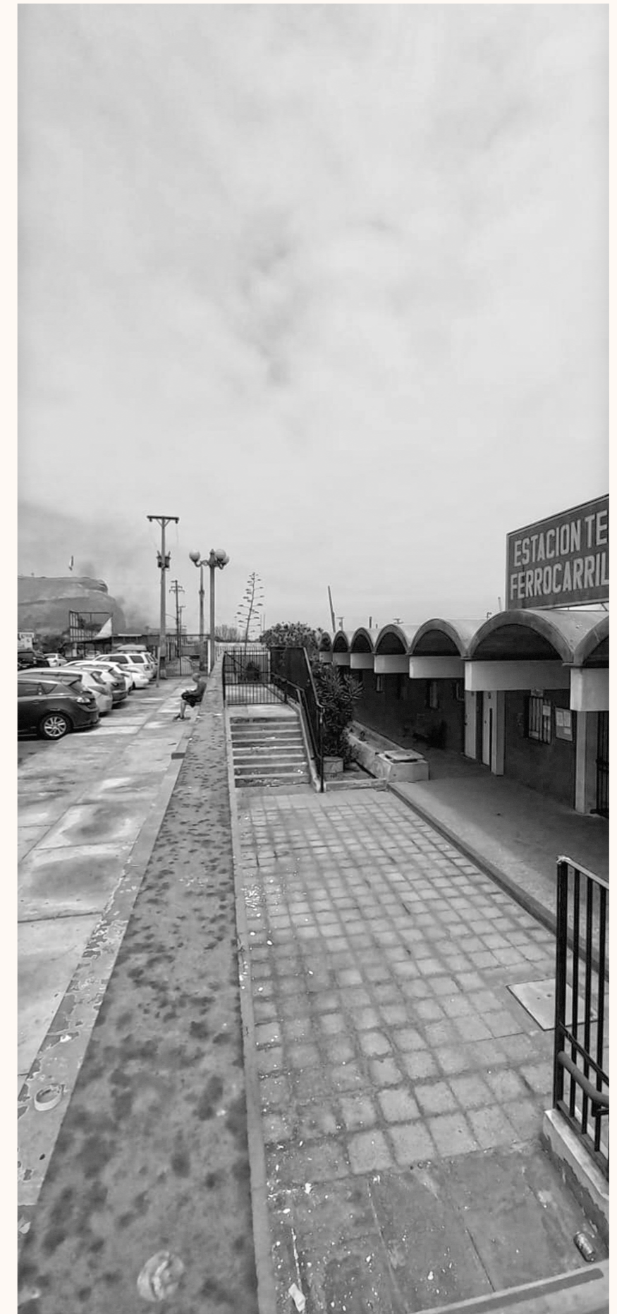
Fotografía 1: Acceso principal Estación Terminal Arica Fuente: Elaboración propia
