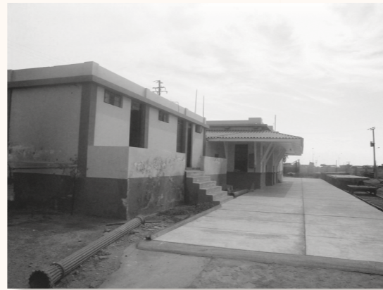
B. EX ESTACIÓN TERMINAL ARICA - TACNA
