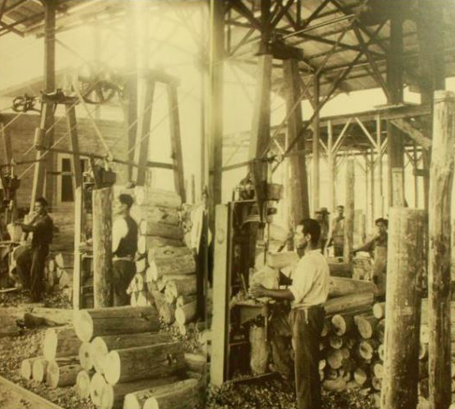
Fig. 14 Primeras máquinas de tratamiento de papel. Primeras formas de tratamiento de la madera, para convertirla en papel. Fuente: tradición y futuro: 1920-2000: 80 años de Wuna gran empresa (Miranda, 2017)W
