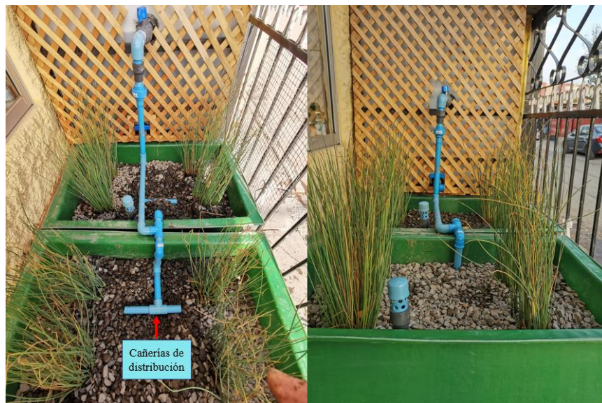
Figura 21. Plantado de humedales, junto a la adición de cañerías de distribución y “treillages” de madera.
