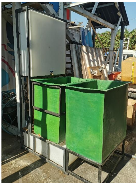
Figura 16. Reconstrucción de la estructura metálica, y adición de estanques para tratamiento biológico.
