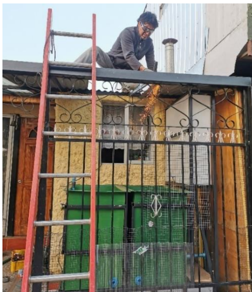
Figura 19. Cambio de material de la cubierta del antejardín.
