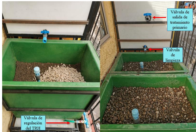
Figura 20. Llenado de humedales construidos con sedimento, adición de soportes y válvulas.
