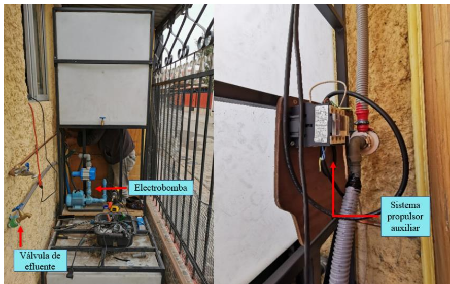
Figura 17. Instalación de sistemas de propulsión de agua.
