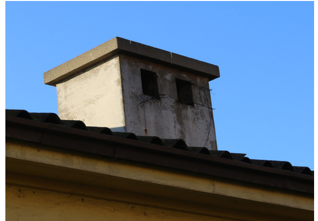
Imagen 105: Detalle remate de ventilación de cocina, 2023 Fuente: Patricia Wyser A.
