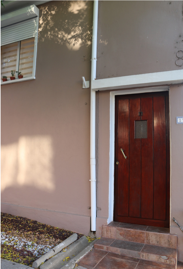
Imagen 98: Detalle puerta de acceso tipo A, 2023 Fuente: Patricia Wyser A.
