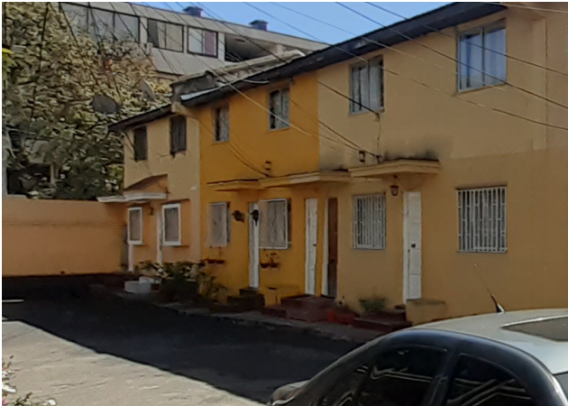
Imagen 86: Detalle ventanas originales, 2023 Fuente: Patricia Wyser A.
