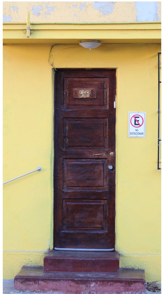
Imagen 88: Detalle puerta de acceso principal original, 2023 Fuente: Patricia Wyser A.
