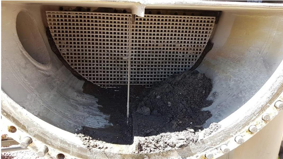
Figura 17: *Preheater* de la central geotérmica Cerro Pabellón con incrustación de material sólido y sedimentación de material detrítico. Fotografía de Germain Rivera.
