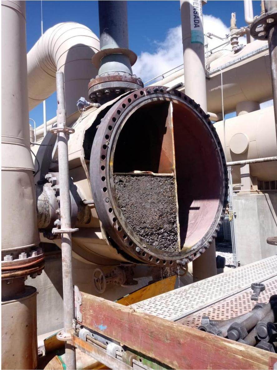
Figura 28: Abertura de preheater para limpieza de material sólido incrustado y depositado. Fotografía de Germain Rivera.
