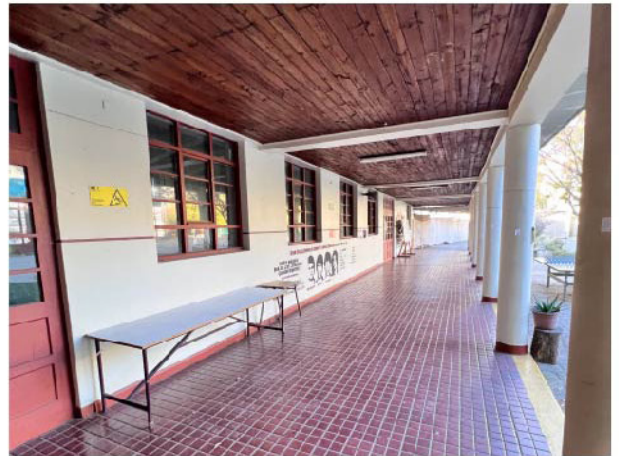
4. Corredor cubierto junto al auditorio y la cancha.
