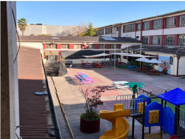
3. Sector patio. En la vista: a la izquierda la cubierta del casino y al fondo el auditorio con el bloque matucana
