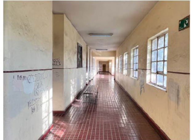
8. Segundo piso. Pasillo central pabellón matucana.
