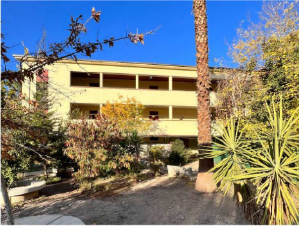
1. Pabellón Chacabuco con salas sin utilizar.
