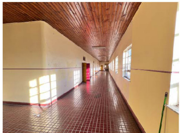
12. Tercer piso. Salas en reparación pabellón matucana.
