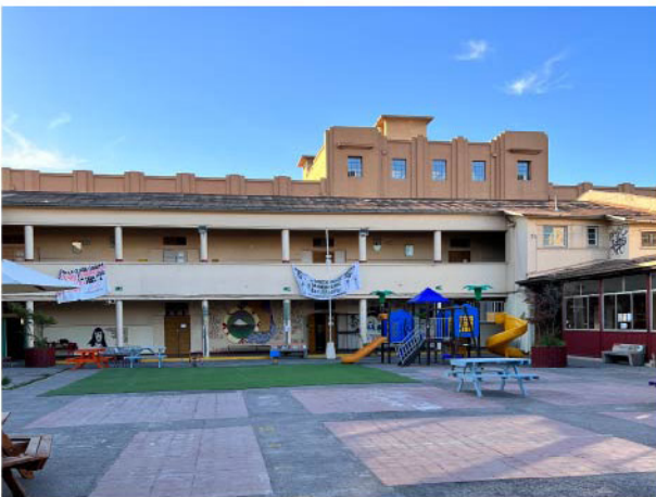
5. Sector del patio mirando hacia el pabellón de calle moneda y en el fondo la Biblioteca de Santiago.
