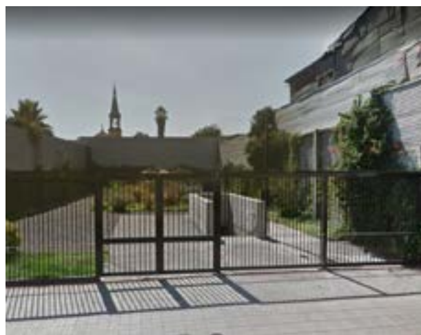
Fig. 08. Construcción subterránea. Fuente: Elaboración propia.
