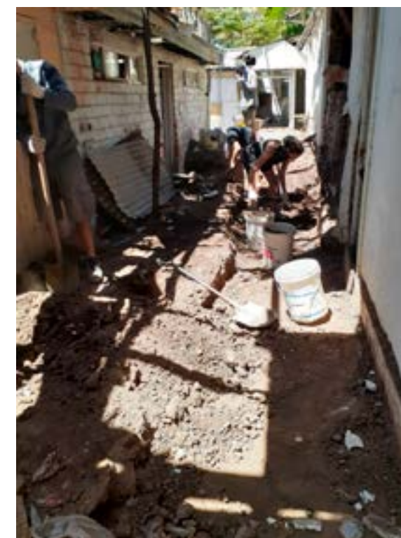
Fig. 13. Proceso de retiro de escombros. Fuente: Elaboración propia.
