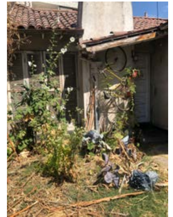
Fig. 17. Entrada Casa Gallito. Fuente: Elaboración propia.
