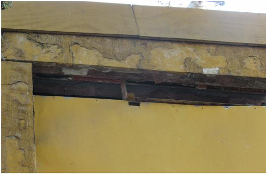
Humedad por filtración en cornisas y muros.
