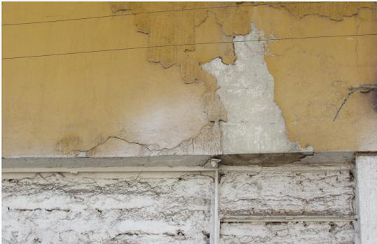
Desprendimiento del material de revestimiento en la fachada.
