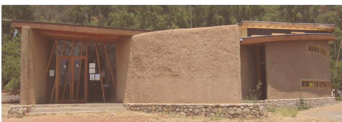
Fig 42: Casa Recepción Fuente: Altosdecantillana.org
