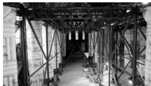
Fotografía interior de estructura en Basílica del Salvador. (2022).
