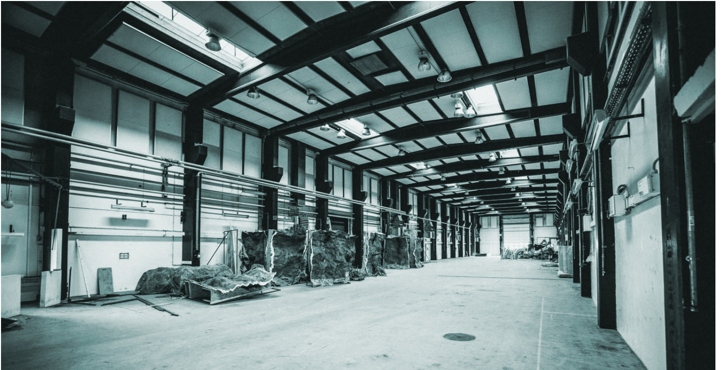
Figura 12: Interior edificio industrial en desuso antes de proyecto GAME StreetMekka Viborg, Dinamarca. Fuente: sitio web oficina de Arquitectura EFFEKT.
