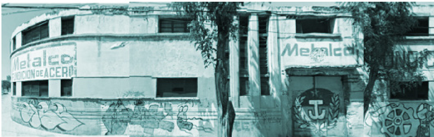
Figura 45: Levantamiento fotográfico exterior Fachada norte / Calle Presidente Errazuriz ex Fundación Metalco. Fuente: Merino, C. Tesis Escuela Nacional de Carnaval, 2010.
