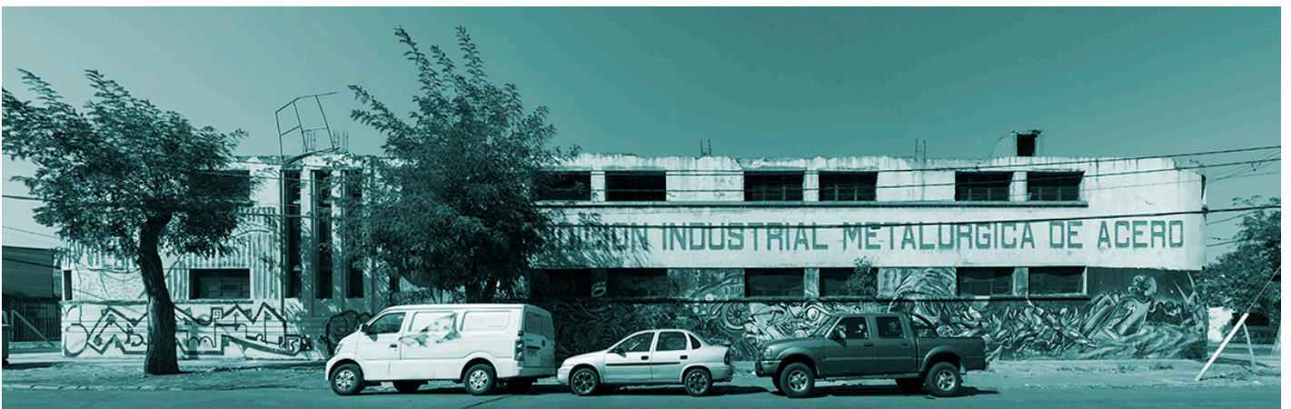
Figura 3: Inmueble de Conservación Histórica. Ex fundición Metalco, Santiago de Chile. Fuente: sitio web Espacios Revelados.
