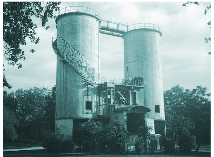
Figura 4: Silos Fábrica de Cementos Melán. Fuente: Frank Baudu.
