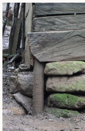
Cimiento de adobe de gallinero Fuente: Archivo propio
