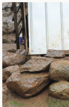
Cimiento de piedras de bodega Fuente: Archivo propio
