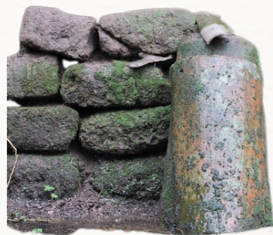
Cimiento de adobe y teja Fuente: Archivo propio
