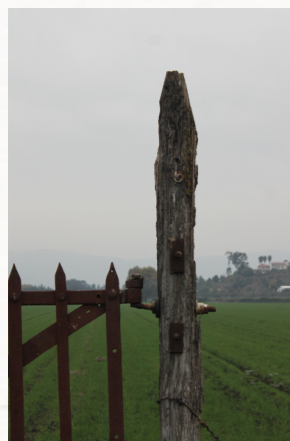
Pilar de cierre de portón antiguo Fuente: Archivo propio
