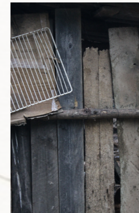
Envoltorio de gallinero Fuente: Archivo propio
