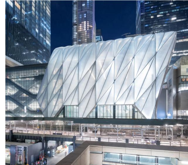
El edificio destaca por su diseño innovador y su capacidad de transformación. Se compone de dos partes principales: un edificio de base fija y una estructura móvil llamada "la cubierta". La cubierta es un elemento único que se desliza sobre los raíles, permitiendo ampliar o cerrar el espacio según las necesidades del programa.
