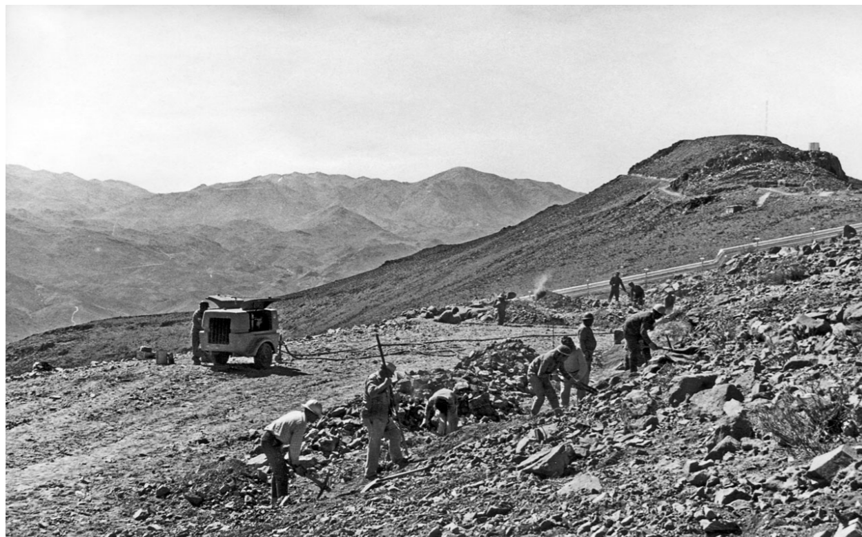
Construcción de carretera en el Observatorio La Silla, 1968 Recuperado de www.eso.org
