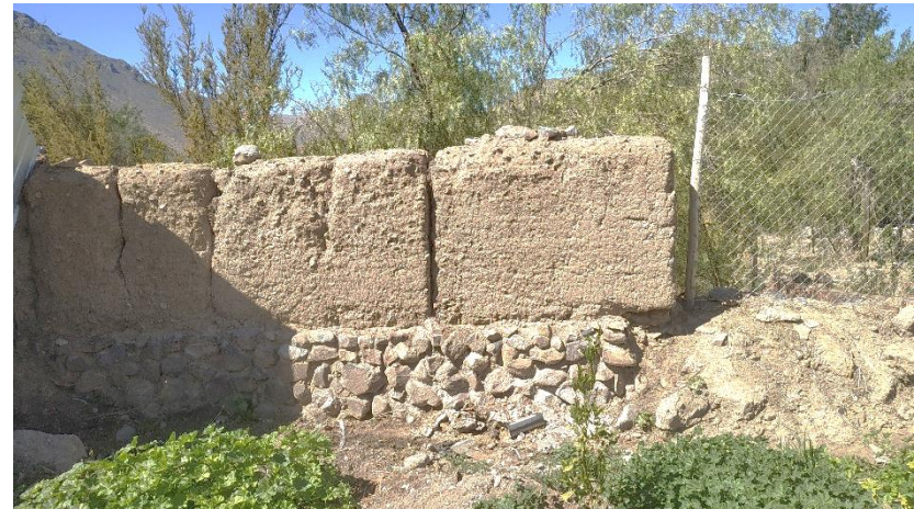
Figura 50: Cerca de tapia sobre cimiento de piedra en Tulahuén. Fuente: Archivo propio.
