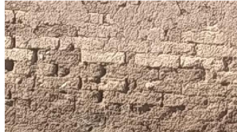
Figura 58: Aparejo a tizón de muros en Tulahuén. Fuente: Archivo propio.
