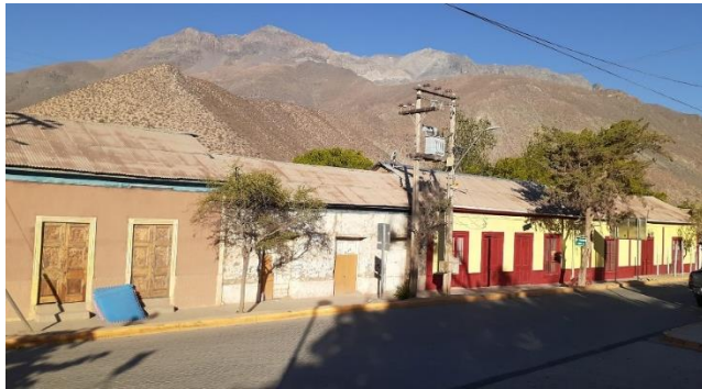
Figura 14: Fotografía de viviendas del centro histórico de Tuluahuén. Fuente: Archivo propio.
