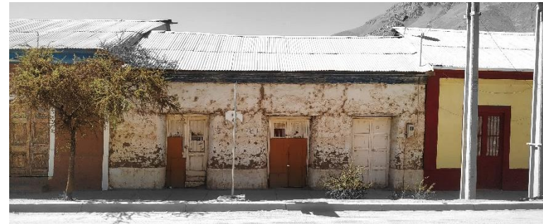
Figura 2: Arquitectura en tierra de Tulahuén, comuna de Monte Patria. Fuente: Archivo propio.
