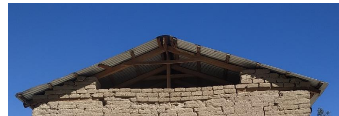
Figura 94: a) y b) Reemplazo del tímpano del muro por madera o placas ligeras; c) Eliminación preventiva del tímpano de muro. Fuente: Archivo propio.
