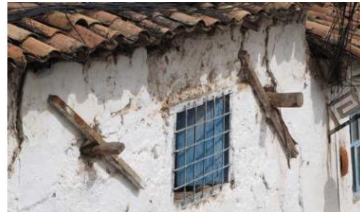
Figura 74: Vista exterior de conexiones de tirantes en Cuzco, Perú. Fuente: Sara Lardinois, 2012.
