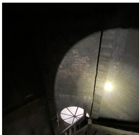
(c) Paños de albañilería reforzados
