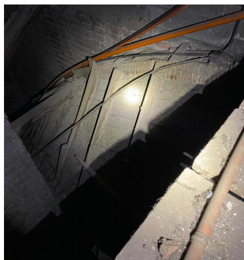
(c) Extradós de bóveda (1/2)
