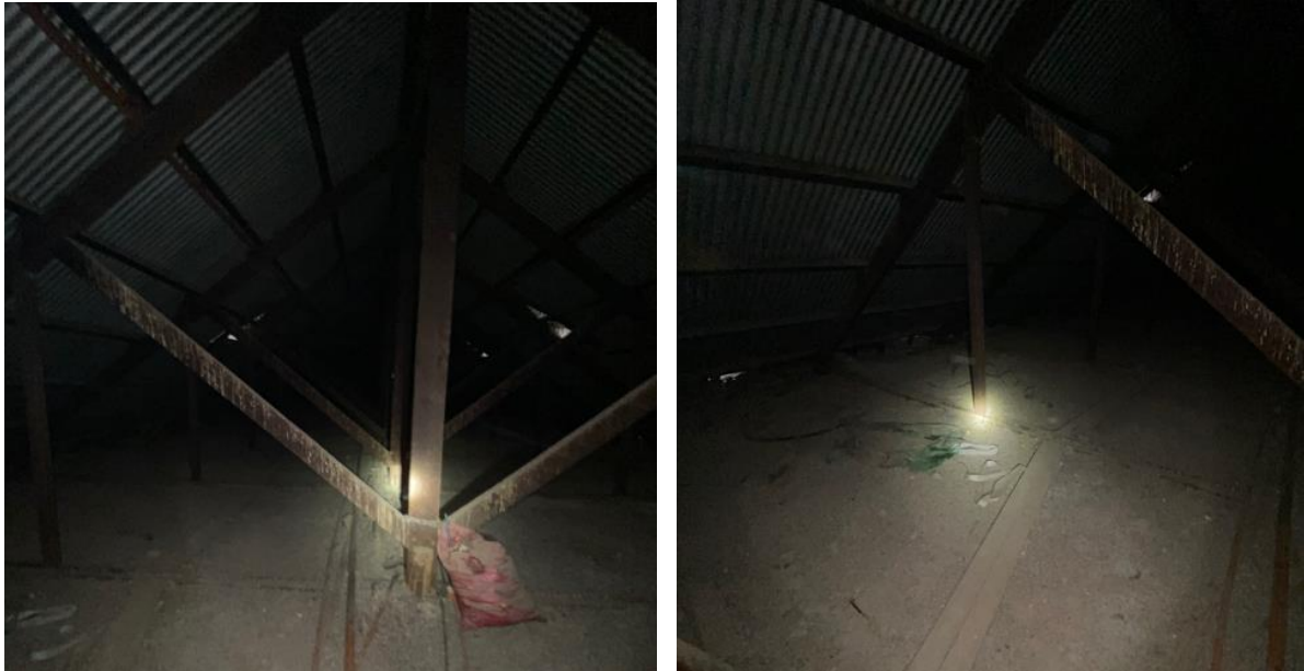
(a) Interior de techumbre
