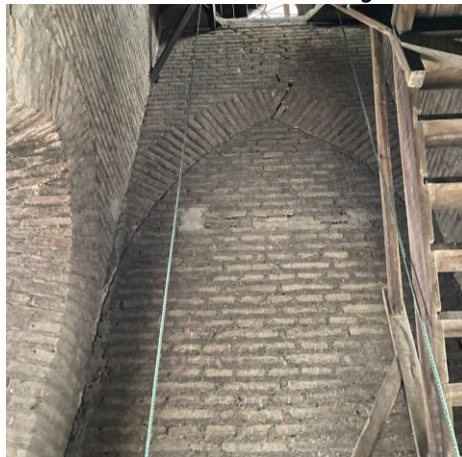
(a) Muro de albañilería y arco de descarga
