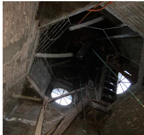
(b) Transición de albañilería a hormigón armado
