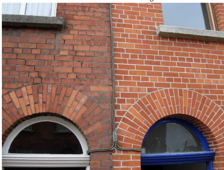
Figura 8.3 Ejemplo de rejuntado. Obtenido de: C&A Building Restoration
