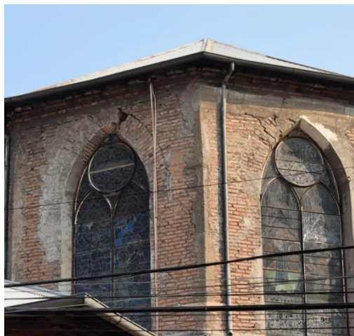
(c) Cadenas de H.A. sobre muros del ábside
