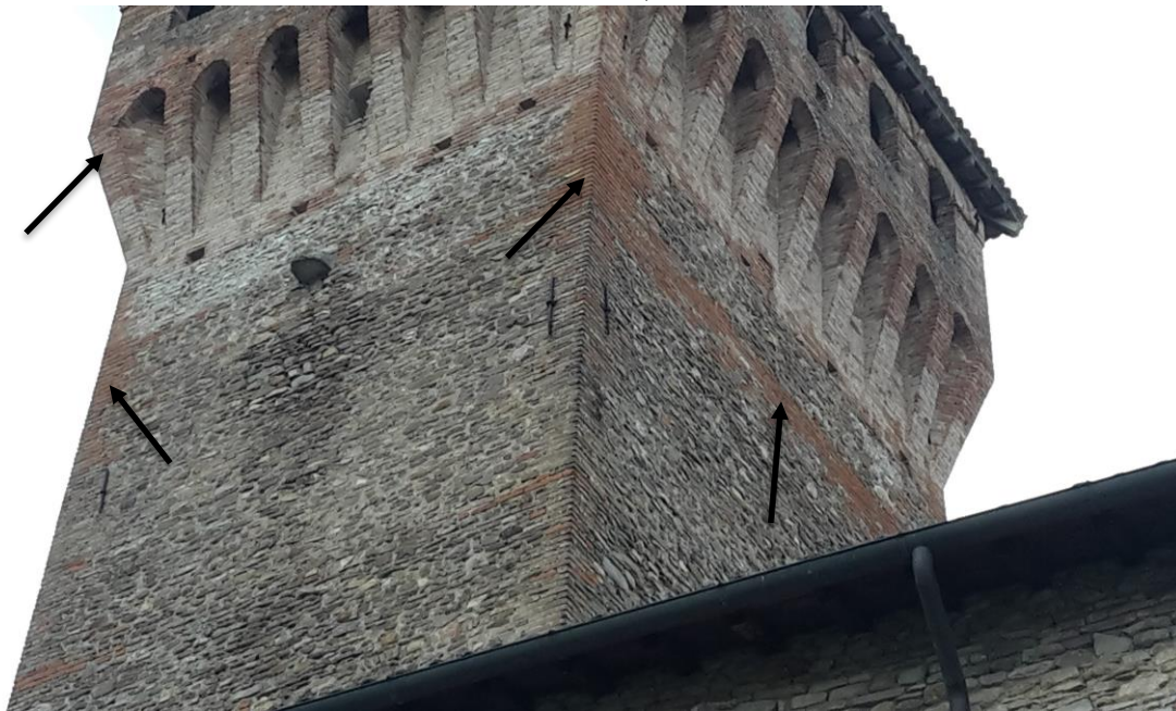
Figura 8.4 Técnica de descoser y coser en el Castillo de Levizzano. Obtenido de: ilcapochiave.it
