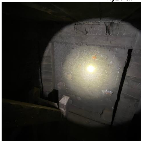
(a) Torre de hormigón armado
