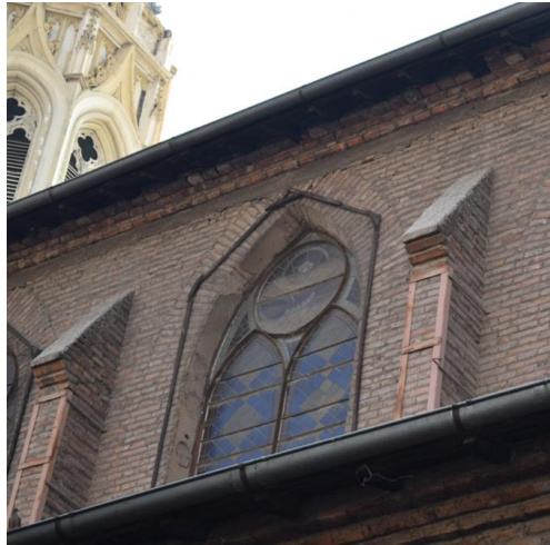
(a) Cadenas de H.A. sobre muros del claristorio
