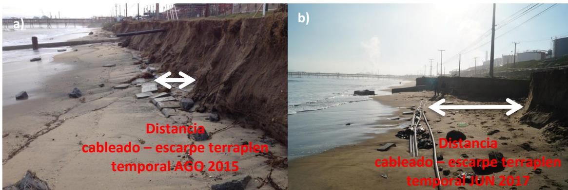
**Figura N° 42:** Fotografías de registro erosión por oleaje en terraplén frente a OXIQUM. a) Exposición de losetas que recubren líneas de transmisión subterráneas, temporal del 8 de agosto de 2015. b) Exposición de líneas de transmisión del temporal de 25 de junio de 2017; en este último hubo un mayor retroceso del terraplén, respecto a temporal de agosto de 2015. **Fuente:** Colección personal.
