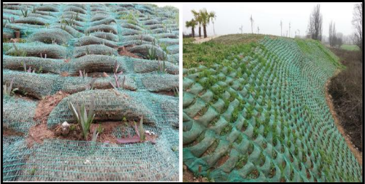
Figura N°9: Talud con tratamiento mecánico y biológico
