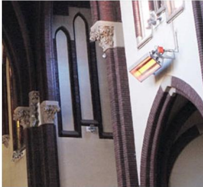
Figura 25. Calefacción mediante emisores Infrarrojos y Figura 26. Radiadores en la Colegiata de San Isidro.
