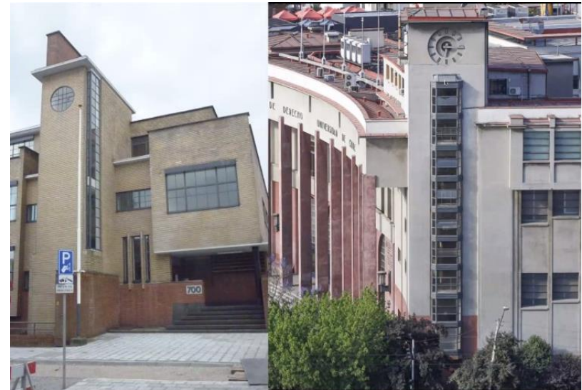
Figura 8. Montaje. Fuente: PPT, BAROS / MIPA 2022
