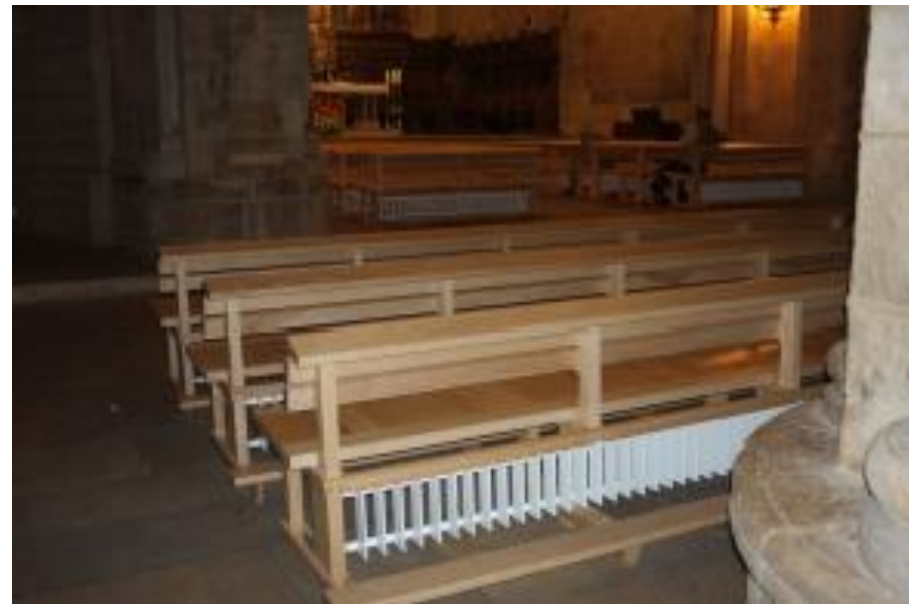
Figura 25. Calefacción mediante emisores Infrarrojos y Figura 26. Radiadores en la Colegiata de San Isidro.
