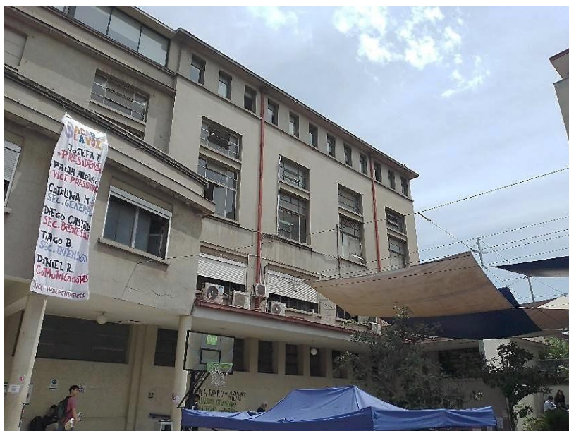
Figura 156. Fachada Interior, Aires acondicionados, Archivo Personal.
