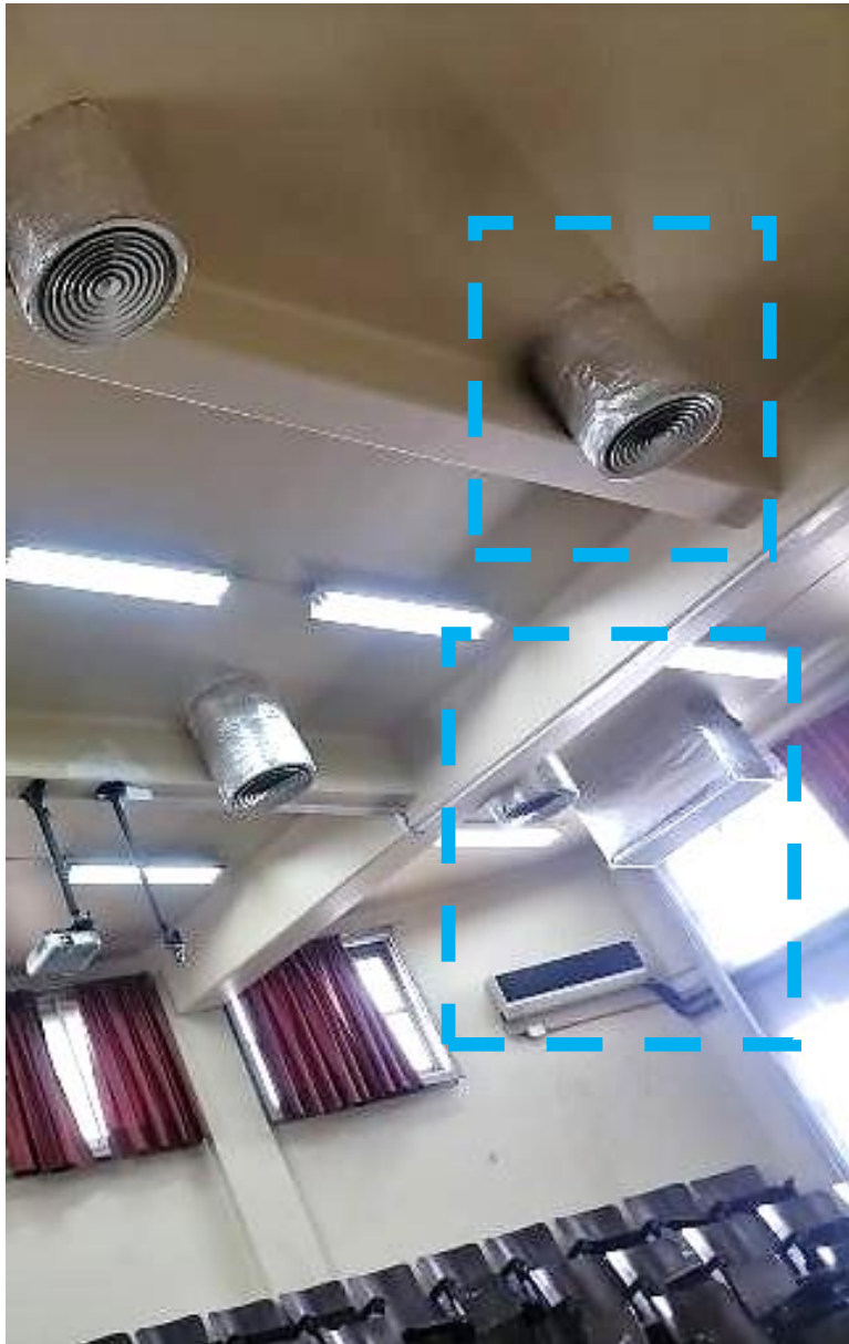
Figura 170. Sala 18, Intervenciones Aires acondicionados, Archivo Personal.
