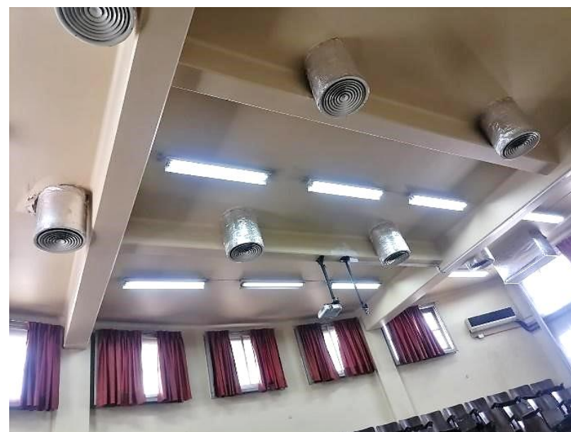
Figura 157. Sala 18, Intervenciones Aires acondicionados, Archivo Personal.
