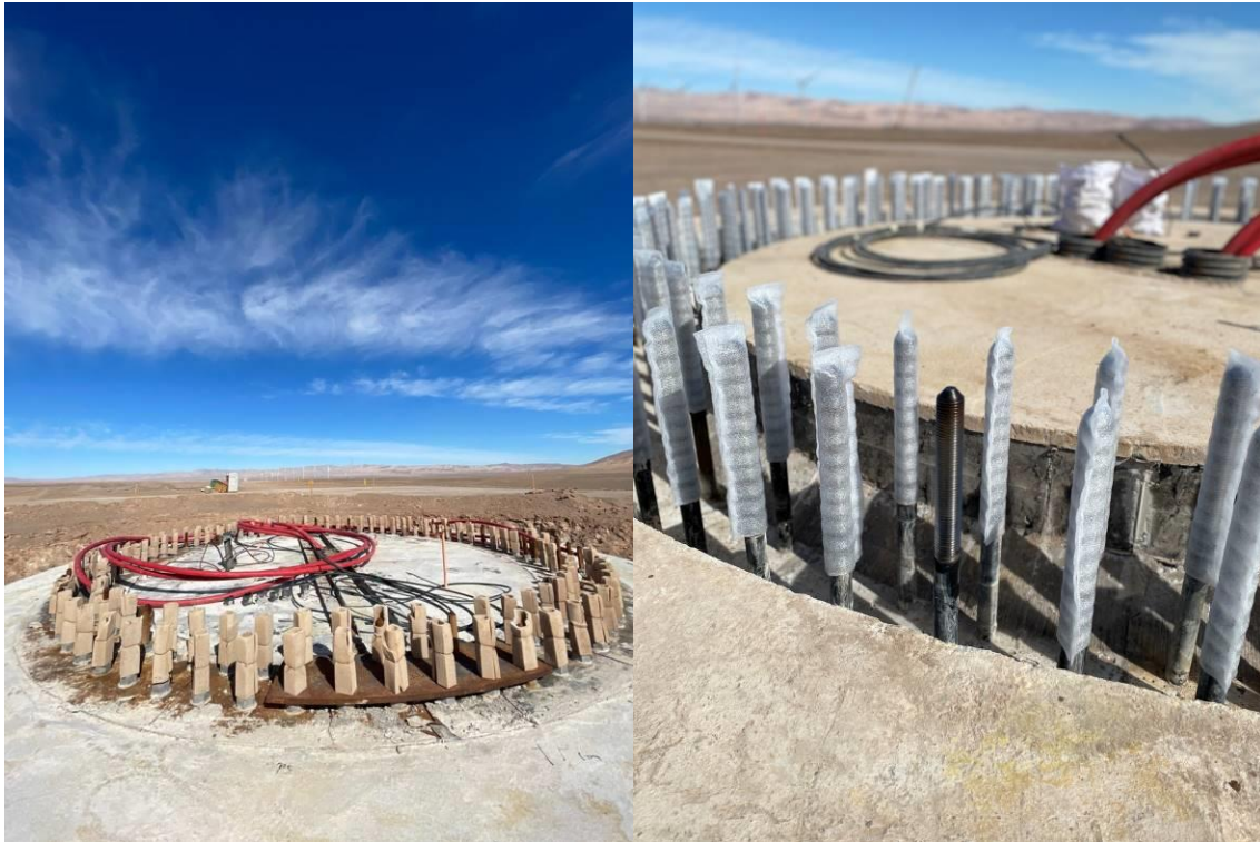
Figura 6 Configuración Pernos de Anclaje Torre Aerogenerador
