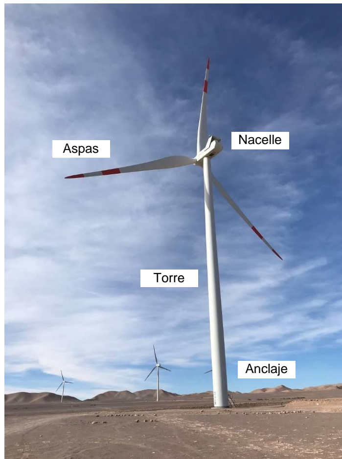
Figura 2 Configuración Típica Aerogenerador Onshore de Eje Vertical
