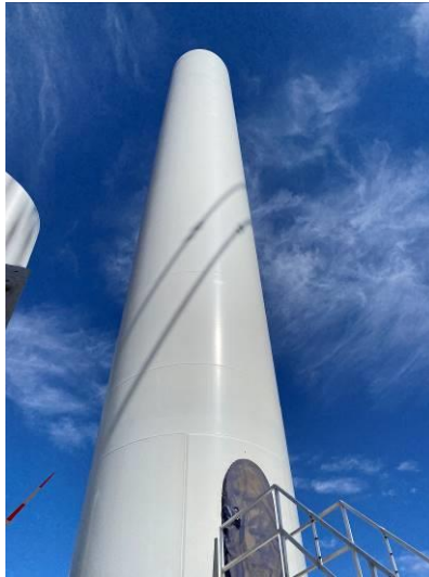
Figura 5 Torres de Acero Aerogeneradores, Proyecto en Montaje Norte de Chile
