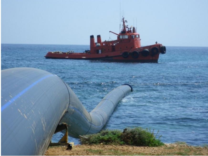
Figura 8.3: Tubería de succión de agua de mar [24].
