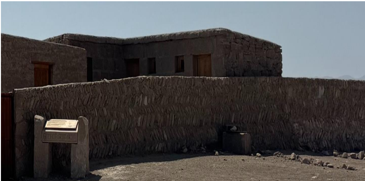
Figura N°60 Pirca, elemento de cerramiento en piedra típico de la zona, elaboración propia
