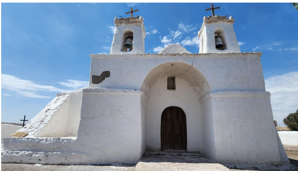
Figura N°4, Iglesia de San Francisco de Asís Chiu Chiu, fuente propia
