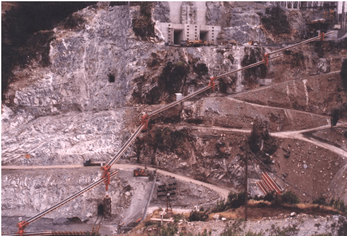
Figura 6.9: Cintas Transportadoras de 910 mm utilizadas en la construcción de la presa Pangué, Fuente: Adolfo Ochoa
