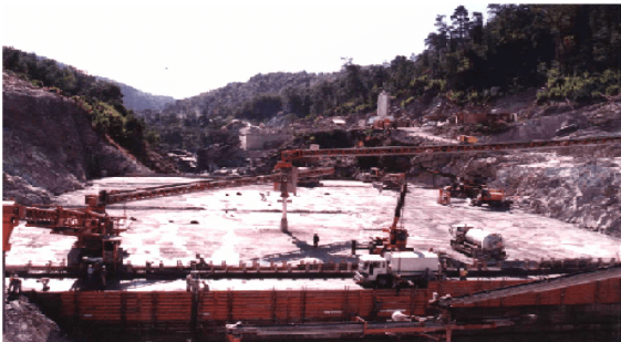
(a) Construcción presa Pangué con hormigón compactado con rodillo
