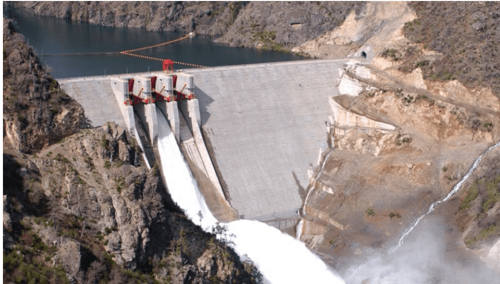
Figura 2.5: Presa Ralco, Fuente: Enel Chile
