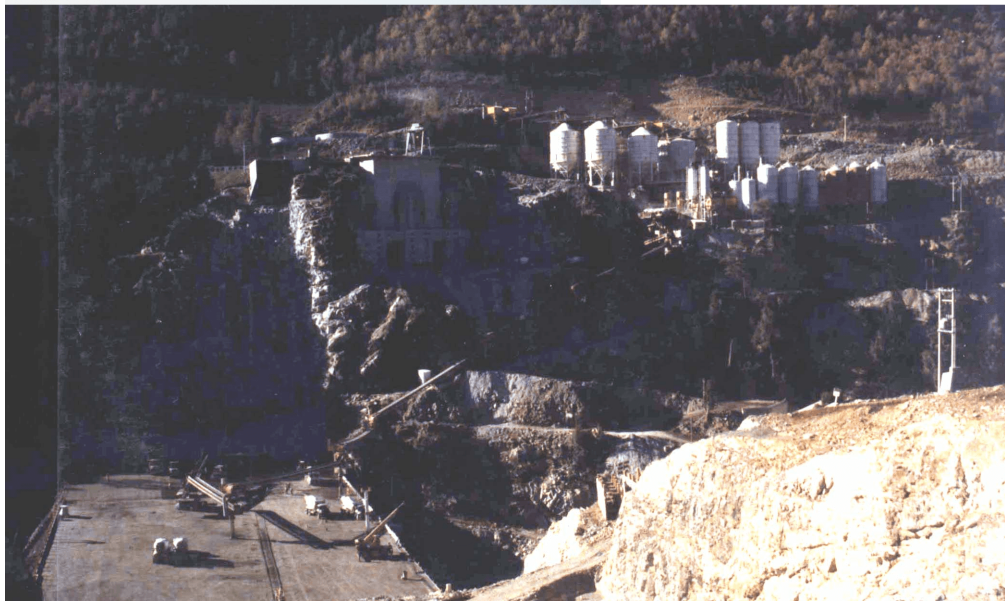
Figura 6.2: Construcción Presa Pangué, Planta de HCR, Fuente: Adolfo Ochoa
