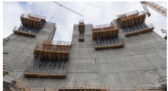
(b) Construcción presa Sarvsfossen con hormigón convencional
