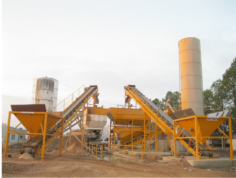
Figura 6.3: Almacenamiento de áridos, Fuente: Asamach
