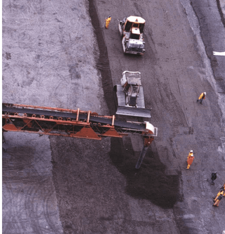
Figura 6.14: Rodillo Vibratorio compactando capa de HCR, Fuente: Adolfo Ochoa
