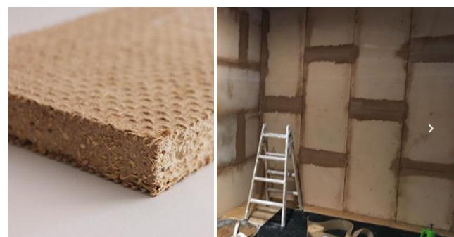
Fig. 4: Instalación de paneles de arcilla ecoclayplac, posterior revestimiento con arcilla,. Fuente: https://ecoclay.es/
