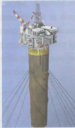
Fig. 2.16: Plataforma Spar
