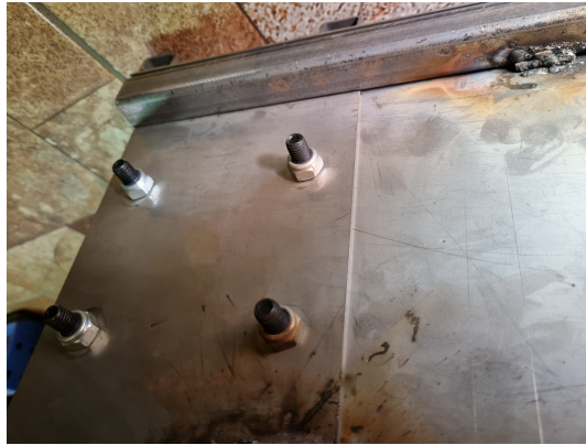
Figura 8.6: instalación Placa refuerzo
