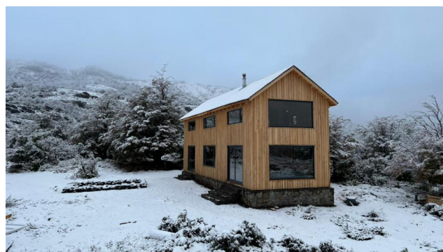
Fig. 2. Imagen referencial caso de estudio. Fuente: Mekis Arquitectos, 2022.
