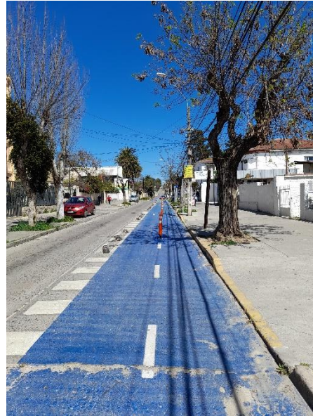
Fig. 13 Ciclovía de emergencia de calle Covadonga. Elaboración propia.
