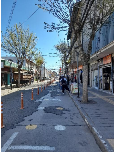
Fig. 12 Ensanchamiento de vereda de calle Andrés Bello. Elaboración propia.
