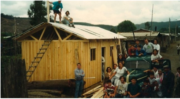
Fig. 3: Construcción de mediagua año 1999. Fuente: Hogar de Cristo.
