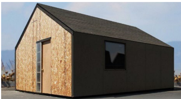
Fig. 8: Casa Elemental Tecnopanel. Fuente: Plataforma Arquitectura.
