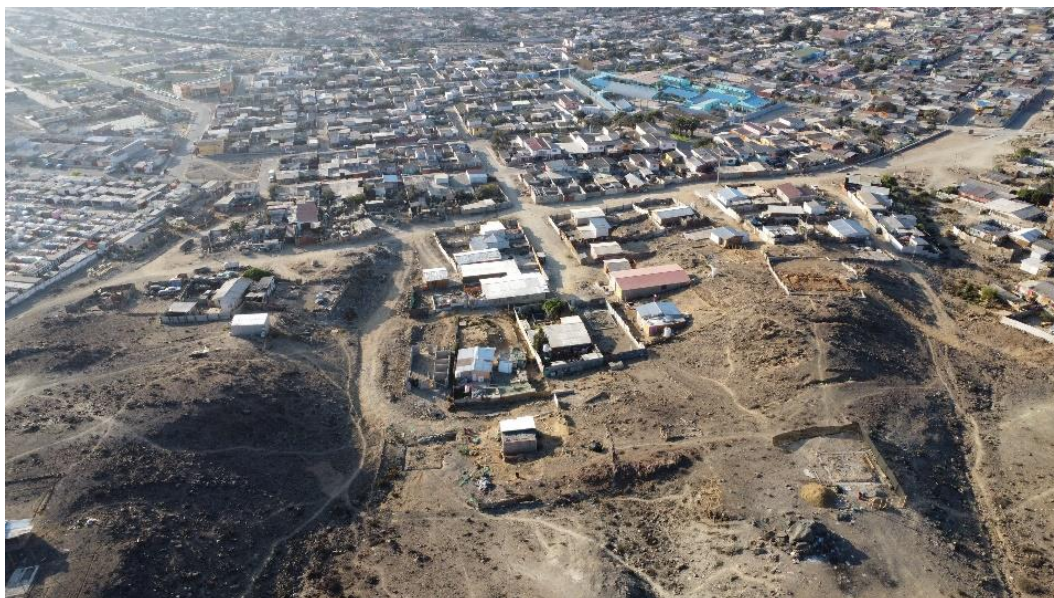
Figura 30: Riesgo de derrumbe en sector Padre Manolo. Fuente: Gabriel Zúñiga R.
