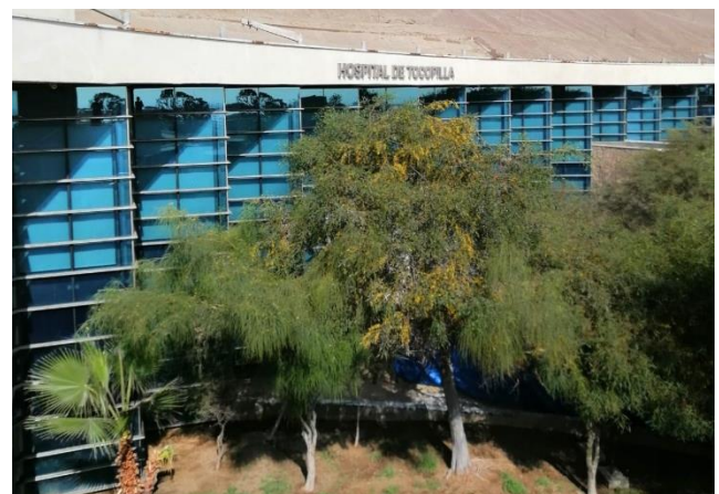
Fig. 2: Fachada norponiente del Hospital Marcos Macuada de Tocopilla. Fuente: fotografía de Lorenzo Cortés T.
