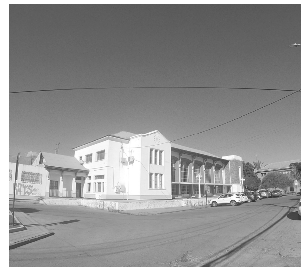
Figura 33: Imagen de la ex estación Ferroviaria, recinto utilizado actualmente para actividades culturales y sede de la corporación Pro Aconcagua. Fuente: Elaboración propia.
