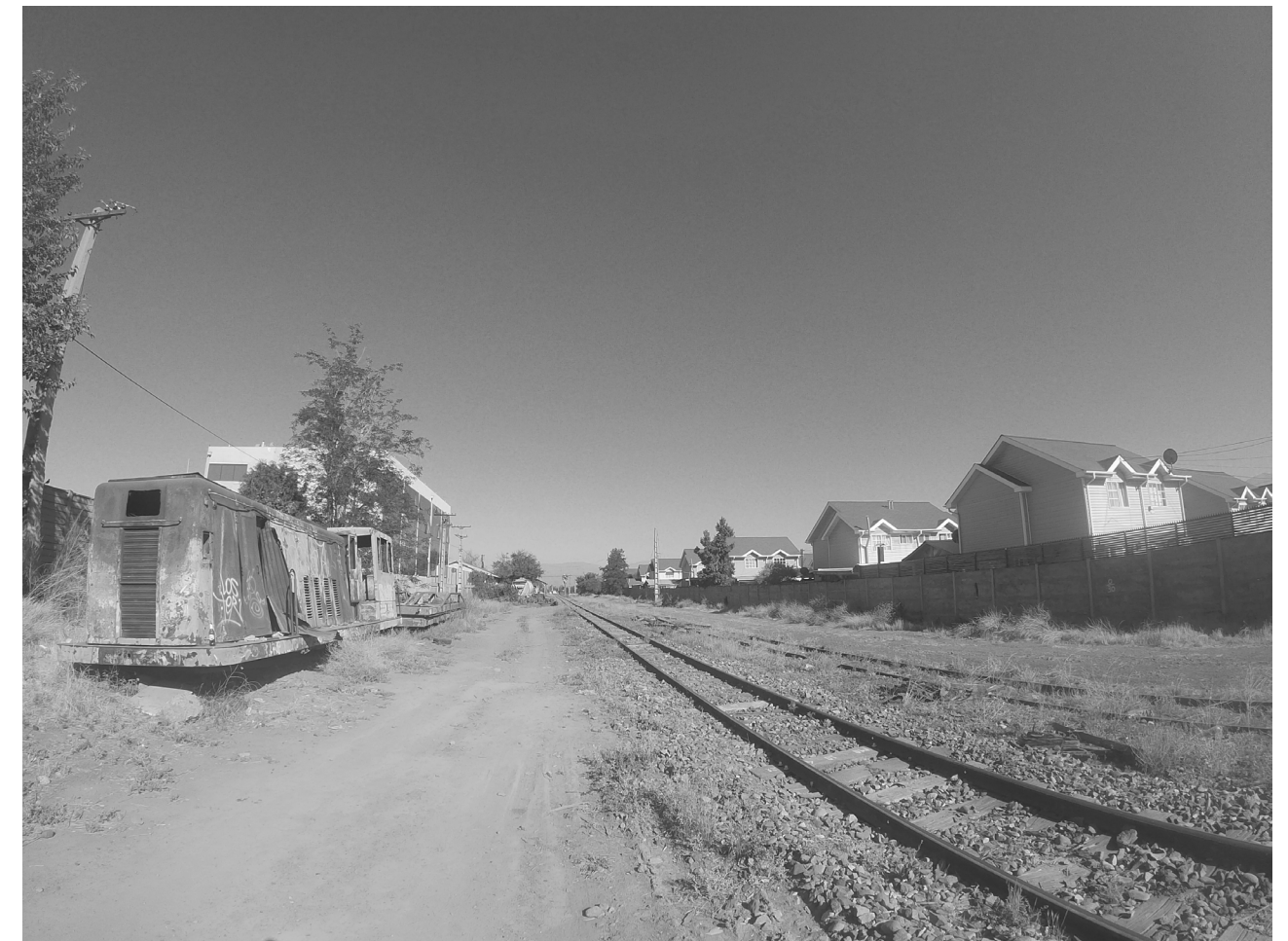
Figura 1: Vía férrea en la ciudad de Los Andes. Fuente: Elaboración propia.
