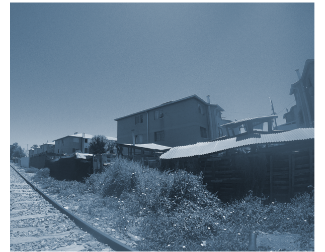
Figura 39: Ampliaciones de viviendas cercanas a la vía férrea. Fuente: Elaboración propia.
