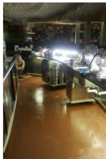
Imagen 7. Aplicación de recubrimiento Copper Armour en piso de restaurant Baco para el control de Listeria. Fuente: Flores (2018)
