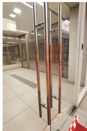
Imagen 5. Aplicación de láminas de cobre autoadhesivas en tiradores de puertas de edificios. Fuente: CUNOV+ (2021)
