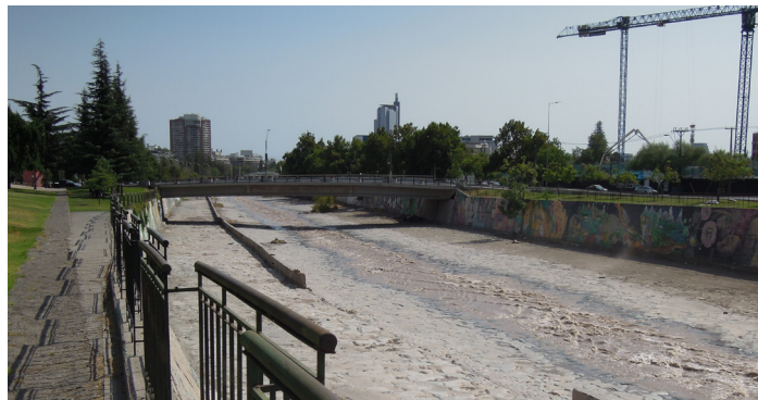
Vista desde el borde entre parque y río.
